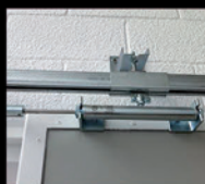
► Pistón hidráulico para puertas Correderas Cortafuegos
